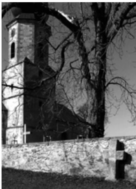
Dřenice: Nové stanoviště u hřbitovní zdi.
