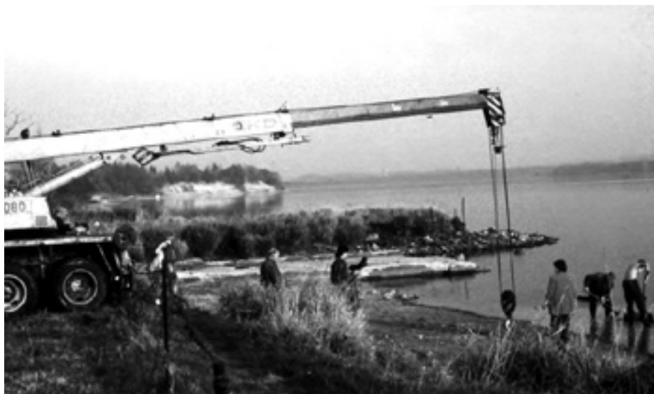
Dřenice: Transfer zlomků kamenného kříže za pomoci autojeřábu.
